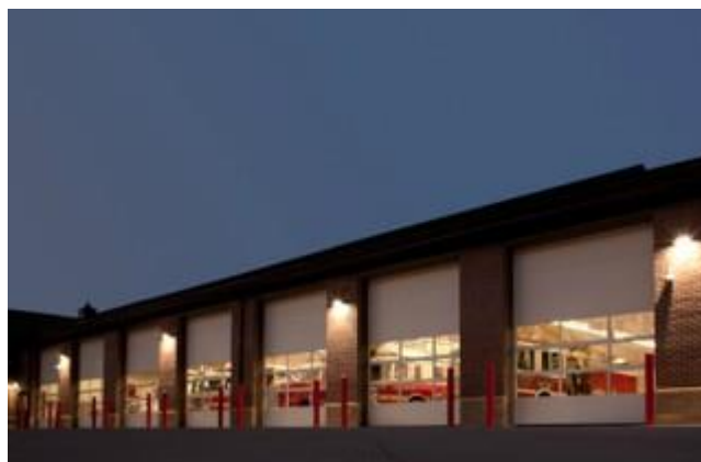
Рис. 6. Реалізація принципу відкритості: панорамне скління гаражних боксів. Пожежне депо в Ілліні, США. Посил.: https://illinigarage.com/service
