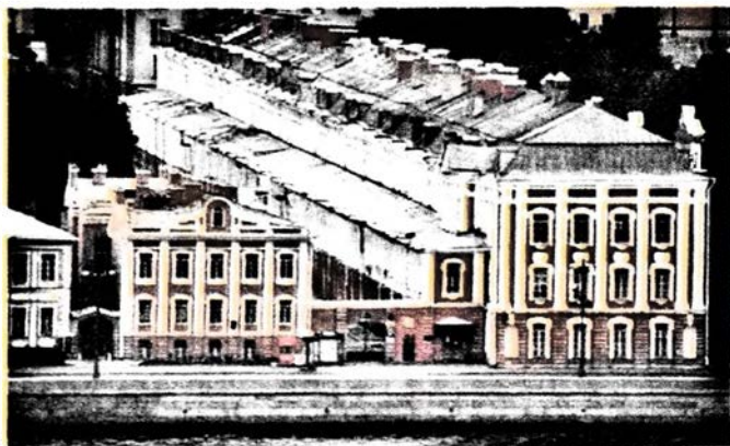
Здание 12 Коллегии в Санкт-Петербурге (арх. Д. Трезини. XVIII в.)
