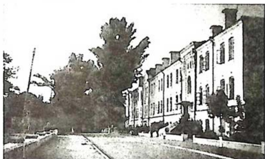
Общий вид здания № 54/42, в котором размещалось приемное отделение и управление госпиталя. Фото начала 50-х годов
